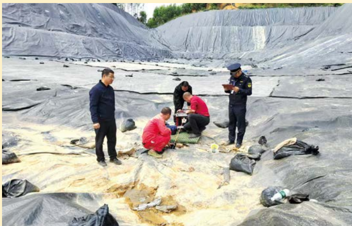
使用管道机器人对生活垃圾卫生填埋场 地下雨污管网进行检查
